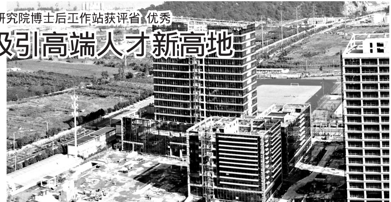
国科大温州研究院新的科研大楼在加速建设中。
