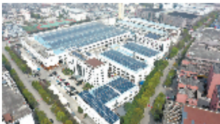
利用企业厂房屋顶建设的光伏发电项目
